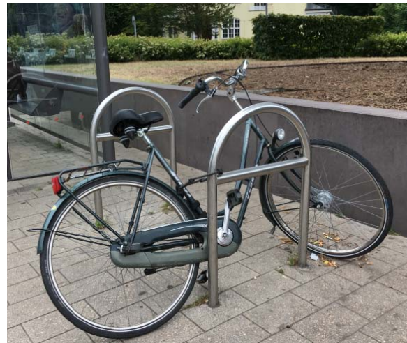
Bild 9: U-förmiger Fahrradständer mit Querholm zur Absperrung aus Edelstahl Rostfrei.
