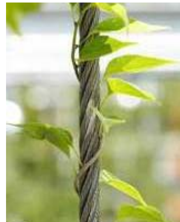
Bild 12: Mit Spannkraft gespannte Drahtseile aus Edelstahl Rostfrei bieten Kletterpflanzen bis in 15 Meter Höhe dauerhaft Halt.
