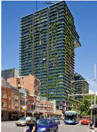
Bild 7: Die Wände der One Central Park Türme in Sydney wurden mit Hilfe einer Konstruktion aus Edelstahlseilen umlaufend begrünt.
