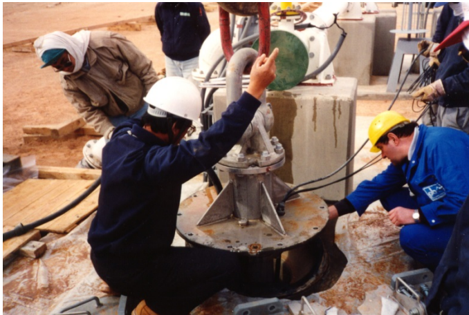
Bild 5: Bei dem weltweit größten Pipeline-Projekt zur Trinkwassergewinnung in der Wüste, dem Great-Man-Made-River-Projekt, leisten Edelstahl-Rohre Schwerstarbeit.
