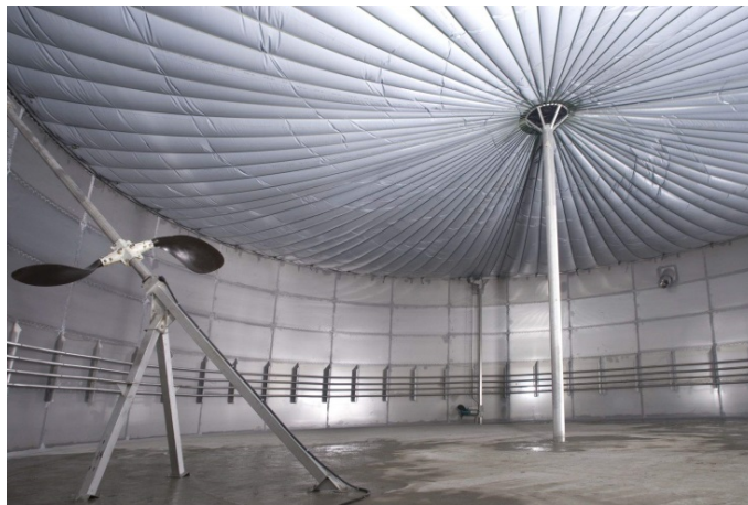
Bild 7: Das Langachsührwerk vermischt das Material im Inneren des Fermenters aus Edelstahl Rostfrei.
