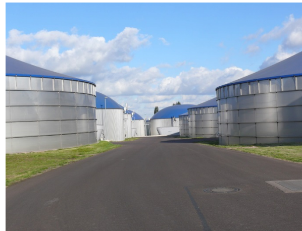
Bild 8: Fermenter und Gärrestelager aus nichtrostendem Stahl sind langlebig und resistent gegen Korrosionsprozesse bei der Biogasgewinnung.
