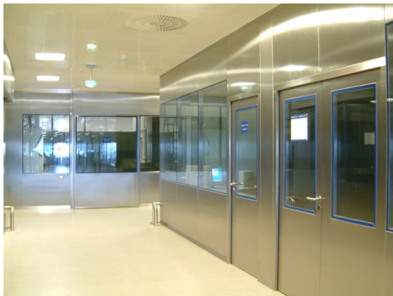
Bild 7: Die Raumbegrenzungen mit Wänden aus Edelstahl Rostfrei ermöglichen eine Fertigung unter Reinraumbedingungen.
