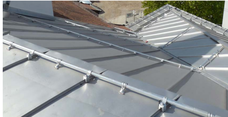
Bild 2: Schneefangrohre und -gitter aus nichtrostendem Stahl hindern den Schnee am Abrutschen.
