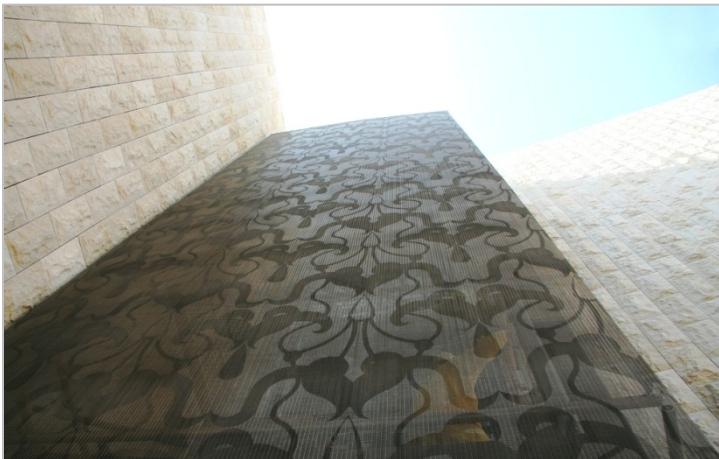
Bild 2: Edstahlgewebe unterstützt als Sonnenschutz die positive Energiebilanz neuer Wohnblöcke in Doha (Katar).
