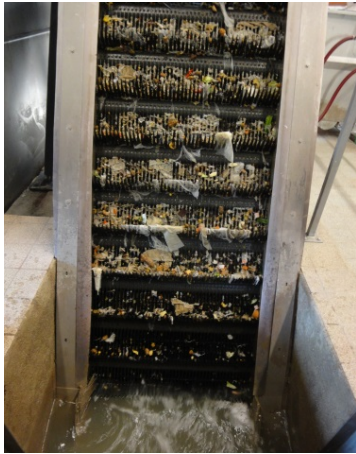
Bild 1: Feinrechenanlagen trennen verbliebene Feststoffe bis zur Größe von sechs Millimetern.
