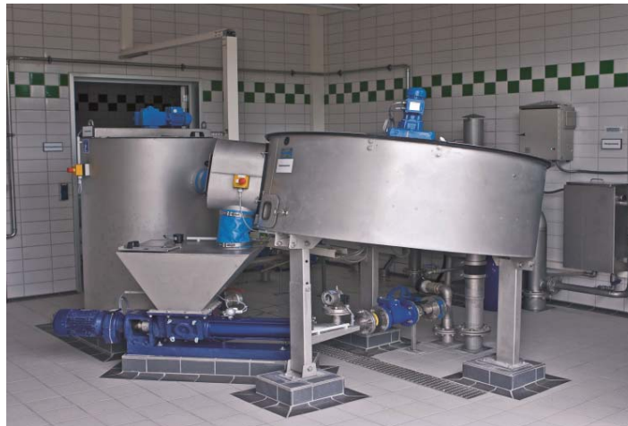
Bild 4: Scheibeneindicker sind trotz ihrer kompakten Bauform sehr effizient. Edelstahlgehäuse kapseln die Anlagen komplett ein und tragen so zu einer sauberen Arbeitsumgebung bei.
