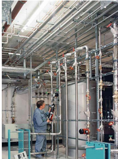
Bild 2: Trinkwassersysteme aus Edelstahl Rostfrei sind gesundheitlich unbedenklich, korrosionsbeständig und langlebig.
