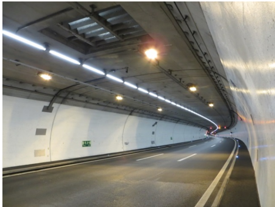
Bild 1+2: Tunnelklappen zur Be- und Entlüftung sowie zur Entrauchung sind zentrale Elemente komplexer Brandschutz- und Lüftungsanlagen in Tunneln
