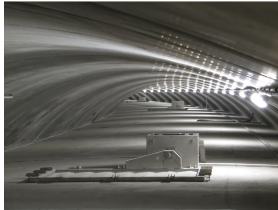
Bild 1+2: Tunnelklappen zur Be- und Entlüftung sowie zur Entrauchung sind zentrale Elemente komplexer Brandschutz- und Lüftungsanlagen in Tunneln
