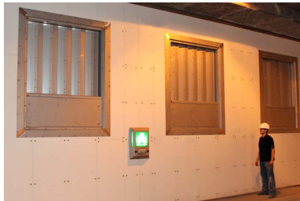
Bild 4: Tunnelklappen aus Edelstahl Rostfrei sorgen für Sicherheit im Brandfall – auch im Hamburger Elbtunnel
