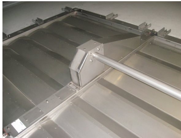
Bild 5-6: In betonierten Zwischendecken installierte Tunnelklappen aus Edelstahl Rostfrei gewährleisten effiziente Entrauchung
