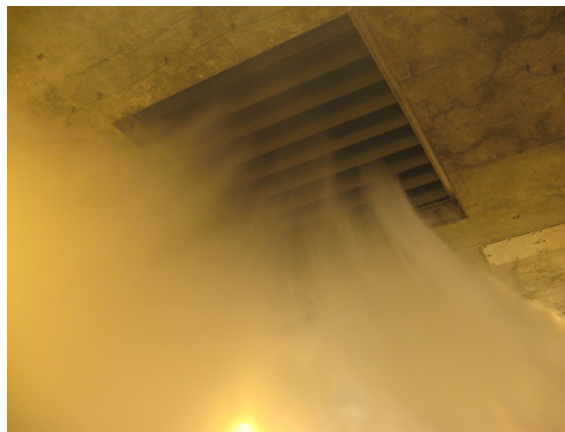
Bild 8: Entrauchungsanlagen mit Tunnelklappen aus rostfreiem Stahl verschaffen bei einem Tunnelbrand Zeit zur Flucht vor giftigen Gasen und Rauch
