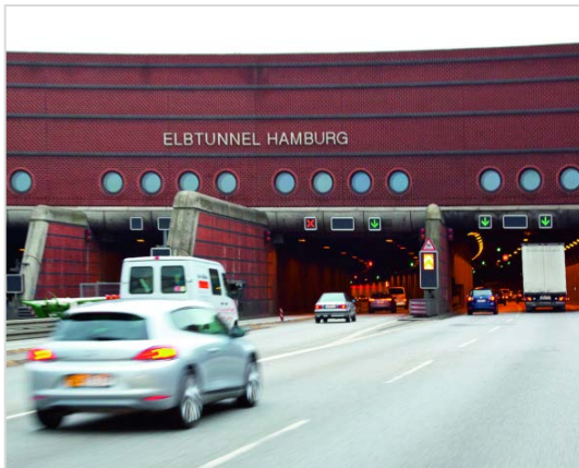
Bild 3: Der Elbtunnel in Hamburg wurde bereits auf den neuesten Sicherheitsstandard laut EU-Tunnelrichtlinie und RABT 2006 gebracht
