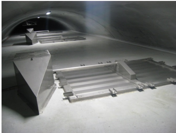
Bild 5-6: In betonierten Zwischendecken installierte Tunnelklappen aus Edelstahl Rostfrei gewährleisten effiziente Entrauchung
