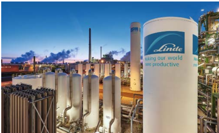
Bild 1: Die für grünen Wasserstoff eingesetzten Systeme erfordern wasserstoffresistente Eigenschaften aller Komponenten: Edelstahl Rostfrei in anwendungsspezifisch ausgelegter Güte ist hier Werkstoff der Wahl.
