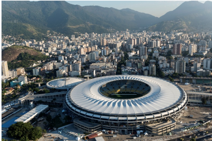
Bild 1: Im legendären Maracanã Stadion in Rio de Janeiro regeln Zutrittssysteme aus Edelstahl Rostfrei die Besucherströme.
