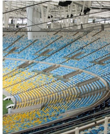
Bild 2: Bei jeder der 64 WM-Begegnungen füllen zehntausende Besucher die Arenen. Modernste Zutrittstechnologie aus Edelstahl Rostfrei ist wie hier im Maracanã Stadion unverzichtbar.
